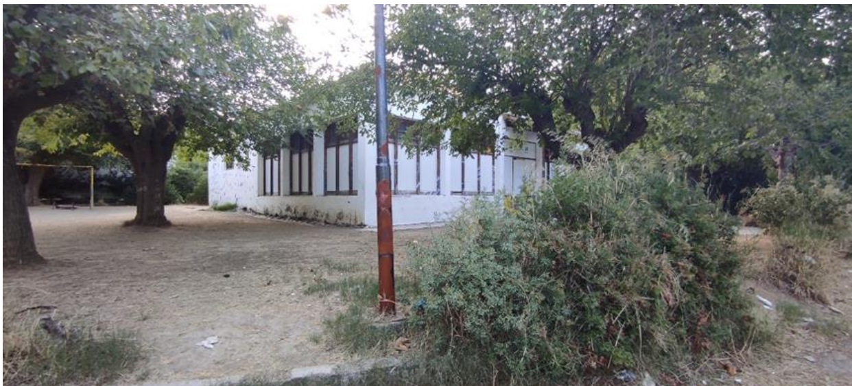
Φωτ. 4.15: Εστιατόριο - Υφιστάμενη Κατάσταση.
