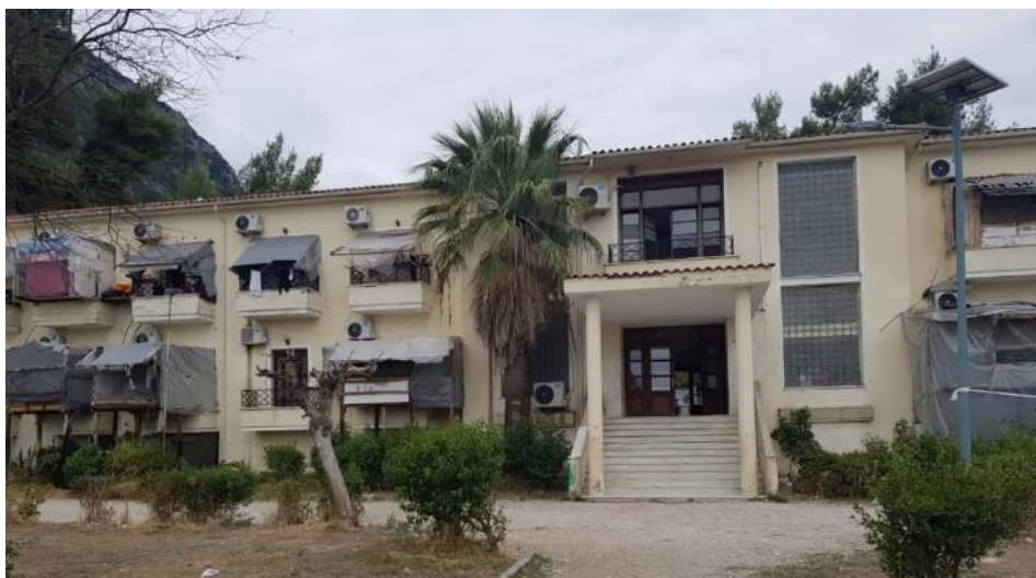
Φωτ.4.9: Ξενοδοχείο ΑΙΓΛΗ - υφιστάμενη κατάσταση.
