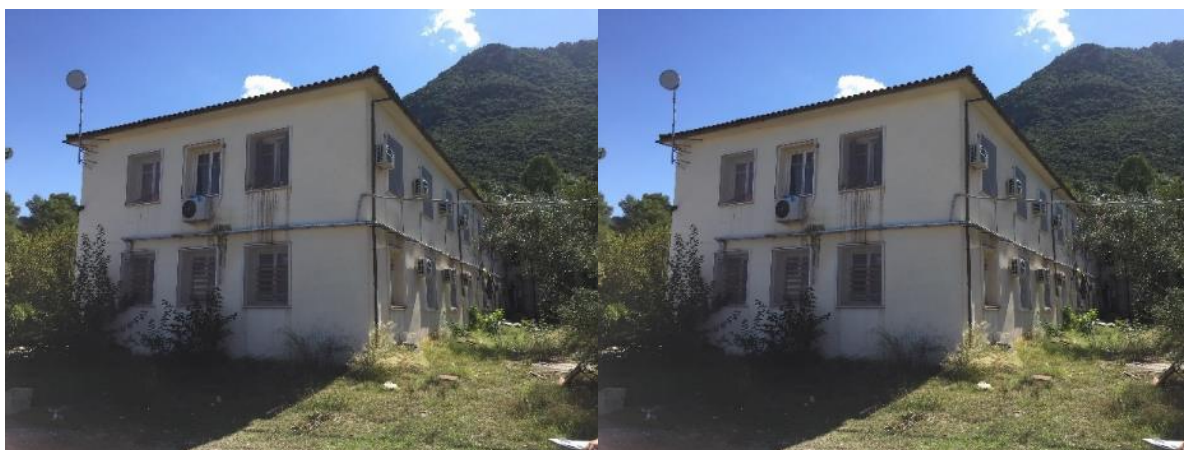
Φωτ. 4.11: Ξενοδοχείο ΑΣΚΛΗΠΙΟΣ - εξωτερικοί χώροι - Υφιστάμενη Κατάσταση.
