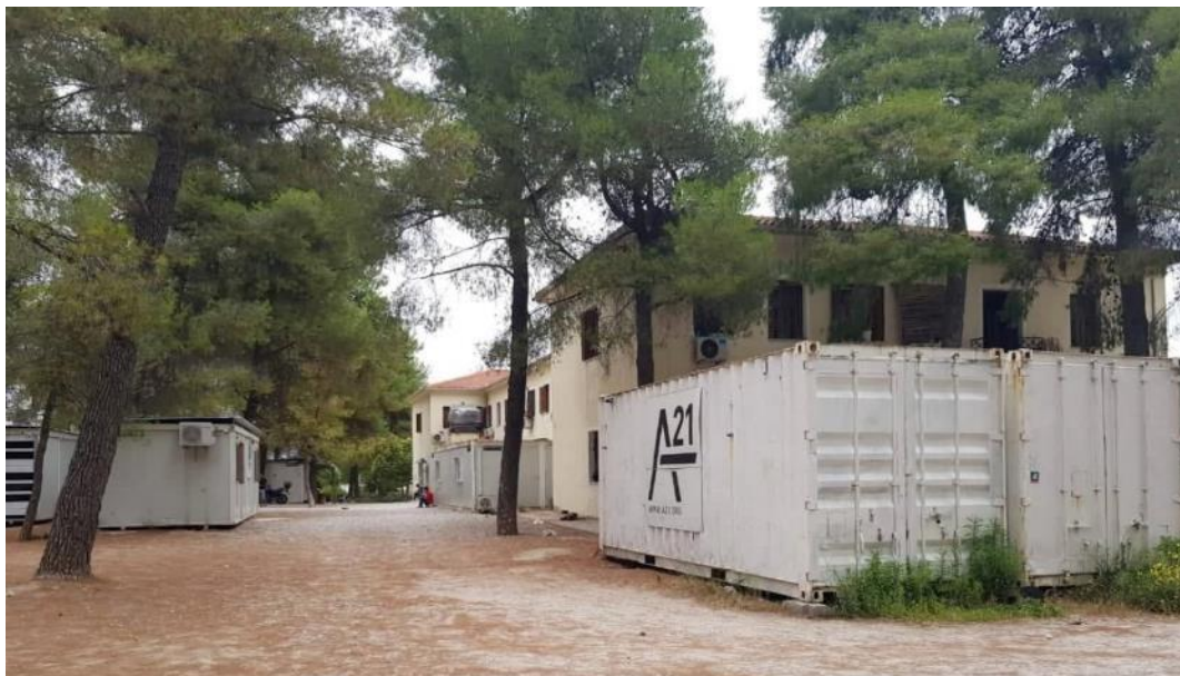
Φωτ.4.8: Ξενοδοχείο ΑΙΓΛΗ και Κοντέινερς, υφιστάμενη κατάσταση.
