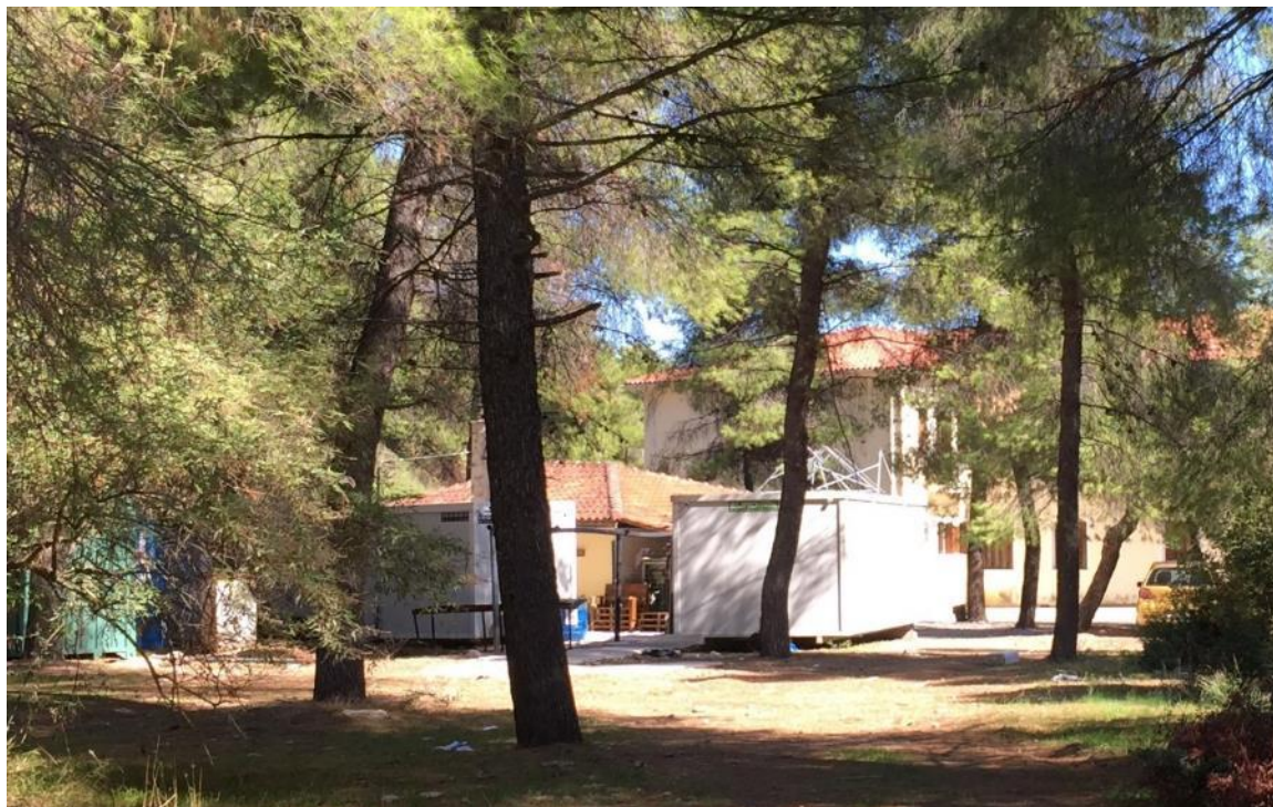
Φωτ. 4.19: Κτίριο Η/Μ Εγκαταστάσεων Αίγλης- Υφιστάμενη Κατάσταση.
