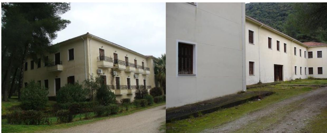
Φωτ.4.10: Ξενοδοχείο ΑΙΓΛΗ πρόσοψη και πίσω όψη.
