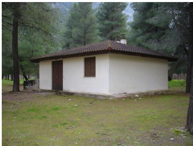
Φωτ. 4.20: Κτίριο Η/Μ Εγκαταστάσεων Αίγλης- Παλαιότερη Κατάσταση.
