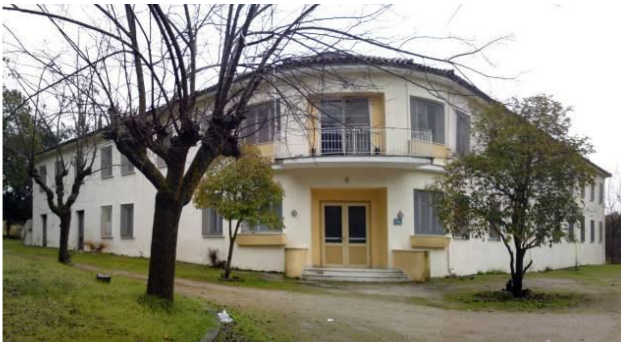
Φωτ. 5: Γενική άποψη ξενοδοχείου Ασκληπιού.
